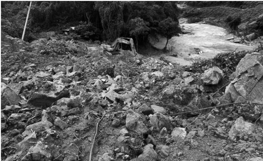
●Đất đá vùi lấp tại khu vực thủy điện Rào Trăng 3. Ảnh: TTXVN.
